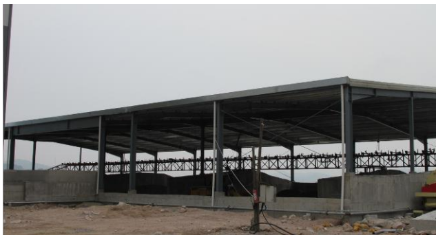
（料场）全封闭结构
